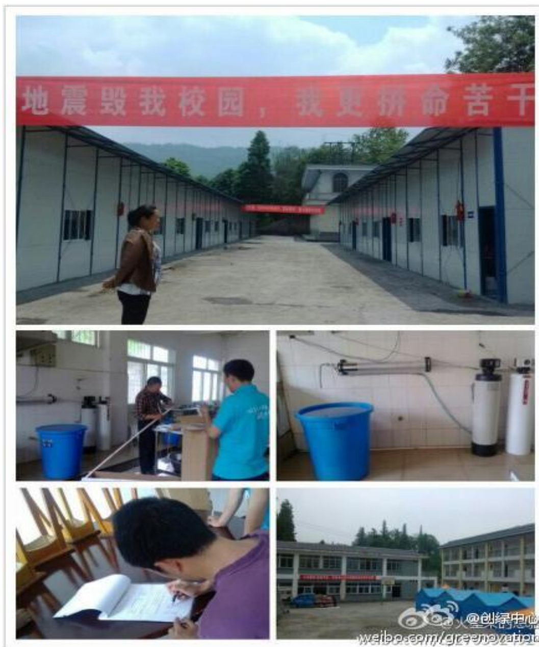
（图：志愿者们正在灾区学校安装净水设备）
