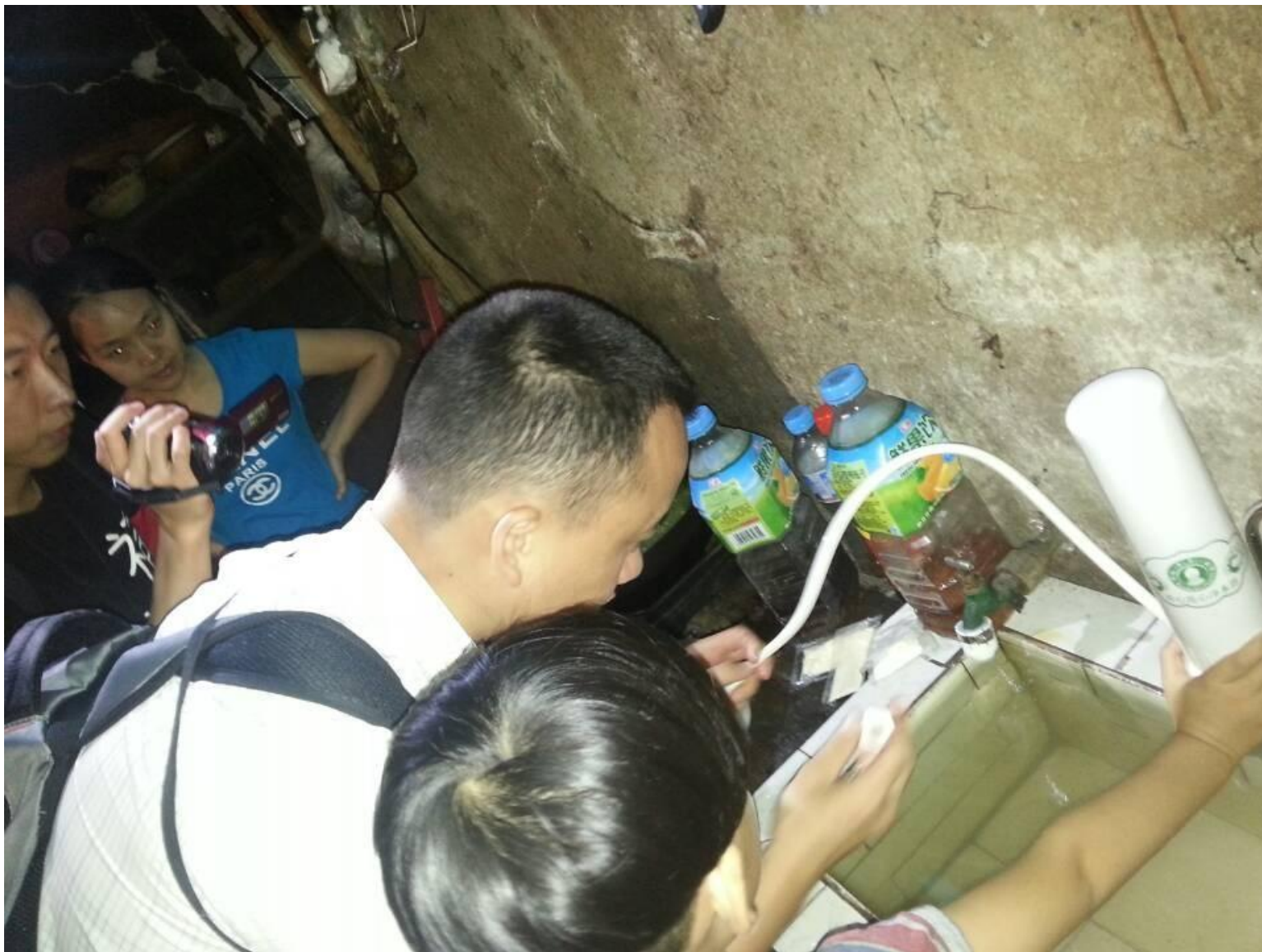
（图：志愿者们在灾区芦山县太平镇村民家中安装简易净水设备）
