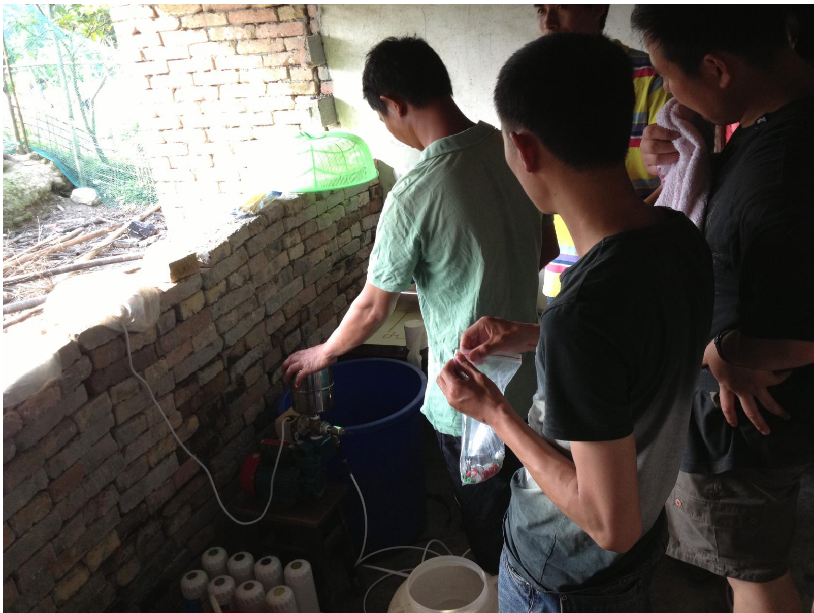
（图：志愿者们在灾区芦山县思延乡村民家中安装净水设备）
