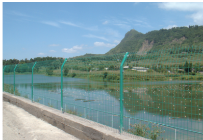
贵州大方农村清洁饮水试点工程
